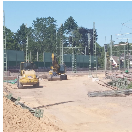
Arbeiten am Horner Bogen
