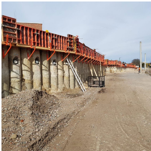
Bau der Stützwände am Horner Bogen
