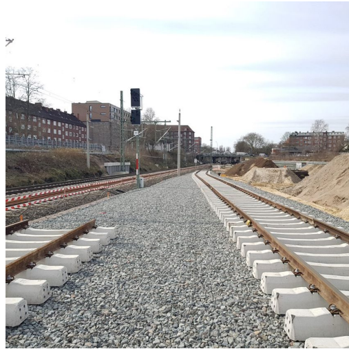
Vorbereitung der Gleise
