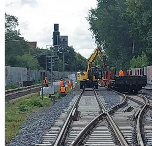
Einbau Weichentrapez Barmbek
