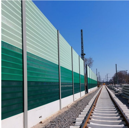
Installation der Lärmschutzwände
